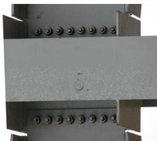
13 Сурет - Ангар конструкциясына бұрандамалық қосылу [5]
