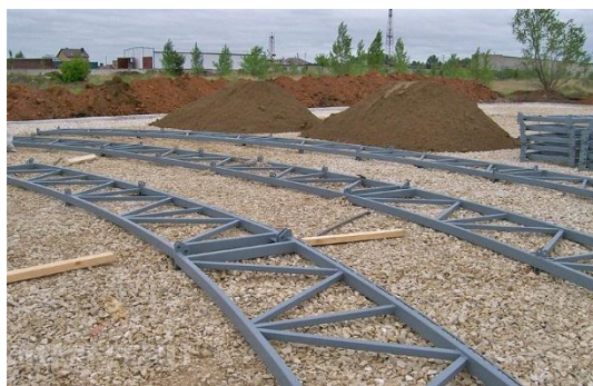
11 Сурет - Цех конструкциясының аркалары [3]
